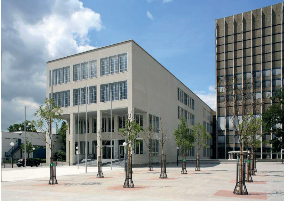
Abb. 30: Erweiterungsbau der Universitätsbibliothek 2006
