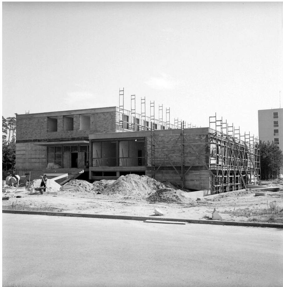
Abb. 5: Gebäude der Literaturabteilung im Bau um 1964
