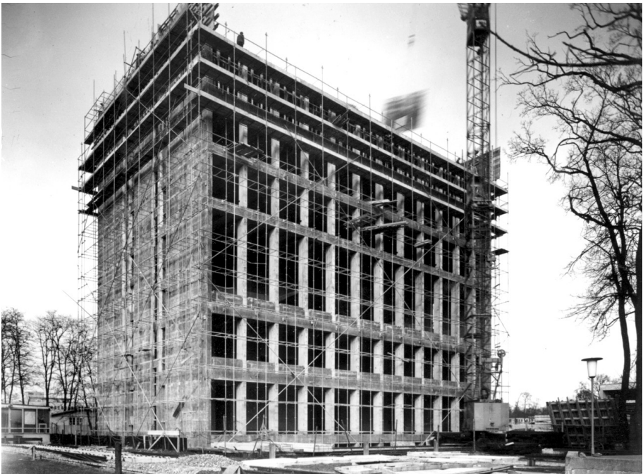
Abb. 19: „Bücherturm“ im Bau um 1965
