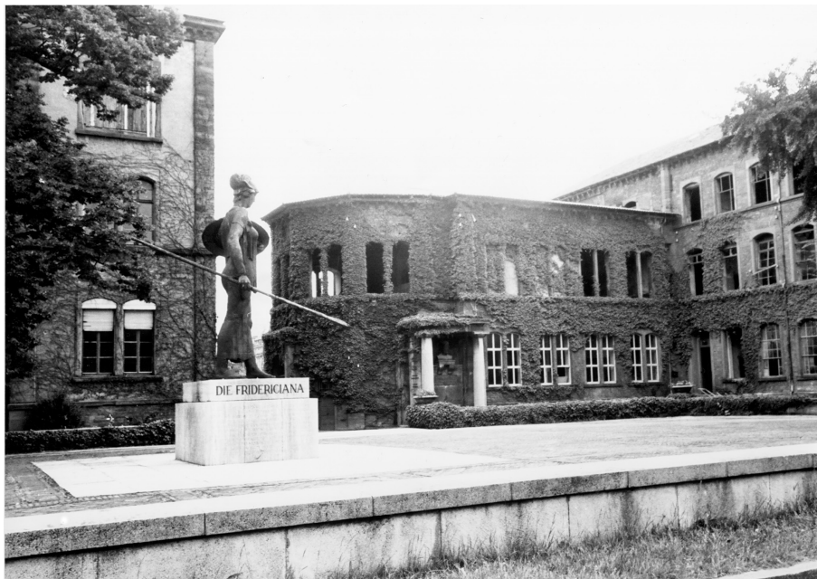
Abb. 12: Blick über den Ehrenhof auf das zerstörte Hauptgebäude um 1950
