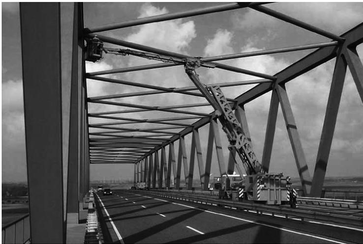
**Abb. 1-3** Einsatz eines Brückenbesichtigungsfahrzeuges [LR Schleswig-Holstein]
