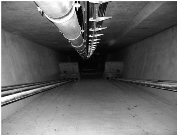
Abb. 6-2 Externe Längsspannglieder in der Talbrücke Nordumgehung Rottweil
