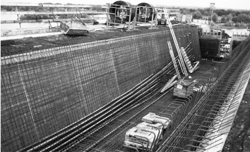
**Abb. 6-3** Illustration der Bewehrungsführung in einer Hohlkastenbrücke, Beispiel Saale-Elster-Talbrücke (Vorspannung im nachträglichen Verbund) [Foto: BBV Systems GmbH]
