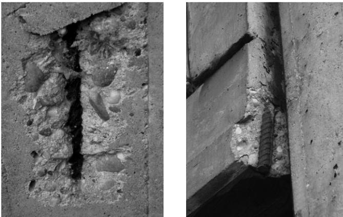
**Abb. 4-2** Sichtbare Brückenschäden
