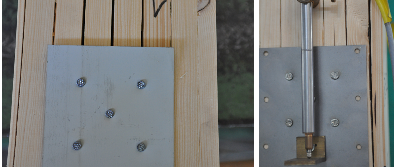
Bild 3-4 Aufweitung der Fugen und Spalten einer Brettlamelle nach dem Einschlagen der Nägel.
