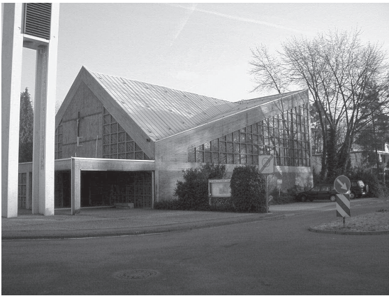
Abb. 3: Kirche vor der Instandsetzung
