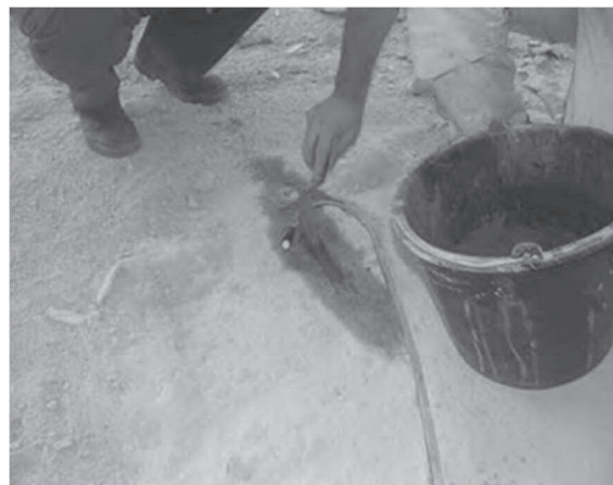
Abb. 2: Einbau einer Referenzelektrode
