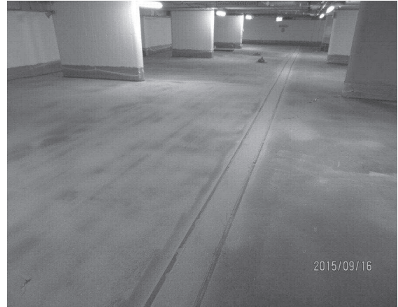
Abb. 18: Dehnfähige Bandage über reprofilierte Arbeitsfuge
