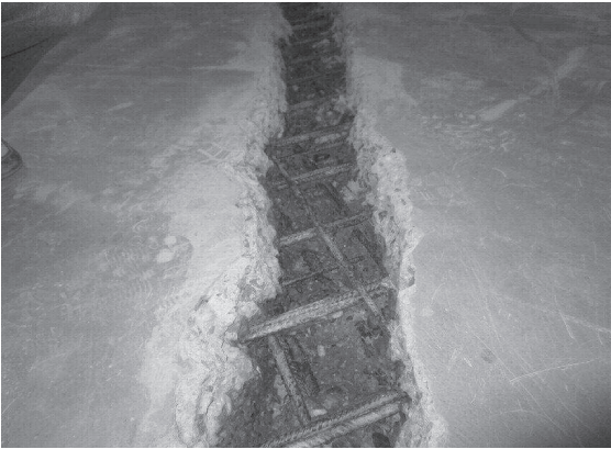
Abb. 13: Bodenriss freigelegt
