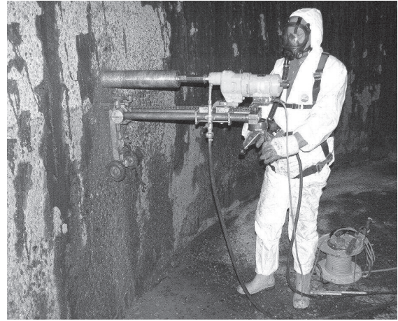
Abb. 4: Bohrkernentnahme in einem Vorversäuerungsbehälter
