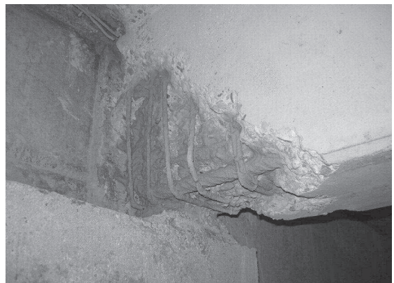
Abb. 18: Mineralischer Korrosionsschutz nur bei örtlicher Instandsetzung mit Entrostung SA 2 ½
