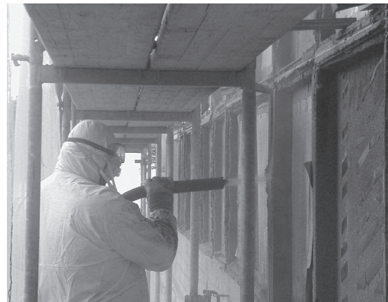
Abb. 7: Reprofilierung der Fensterrahmen mit SPCC
