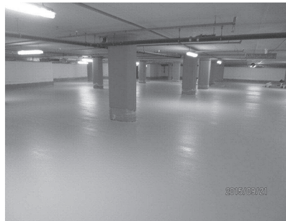
Abb. 19: Beschichtete Boden- und Sockelflächen
