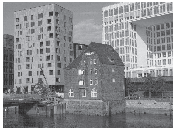
Abb. 1: Beispiel eines zu sanierenden Bauwerks im Bestand
