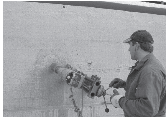
Abb. 5: Bohrkernentnahme in einem Schwimmbad
