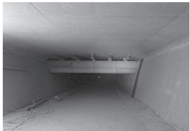
Abb. 16: Übergangsmaßnahme: Unterfangung der geschädigten Fahrbahnplatte des Hohlkastens mit einem Haupt- u. Nebenträgersystem (oben und unten). Unten rechts: Endausbildung
