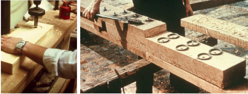
Bild E6-2 Links: Bohren des Bolzenlochs und Fräsen der Vertiefung für den Dübel. Rechts: Zusammenbau einer Verbindung mit zweiseitigen Einlassdübeln (rechts). (STEP 1995 Beitrag C9)
