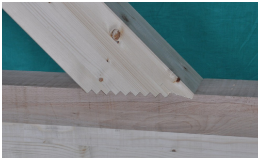
Bild E9-4 Treppenversatz. (Blaß und Enders-Comberg, 2012)
