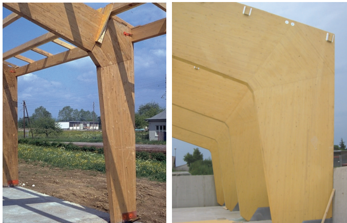
Bild E14-1 Beispiele für geklebte Verbindungen, Rahmenecken mit Universalkeilzinkenverbindung mit Zwischenstück. (Foto links: H. Damm, Foto rechts: H. Brüninghoff)
