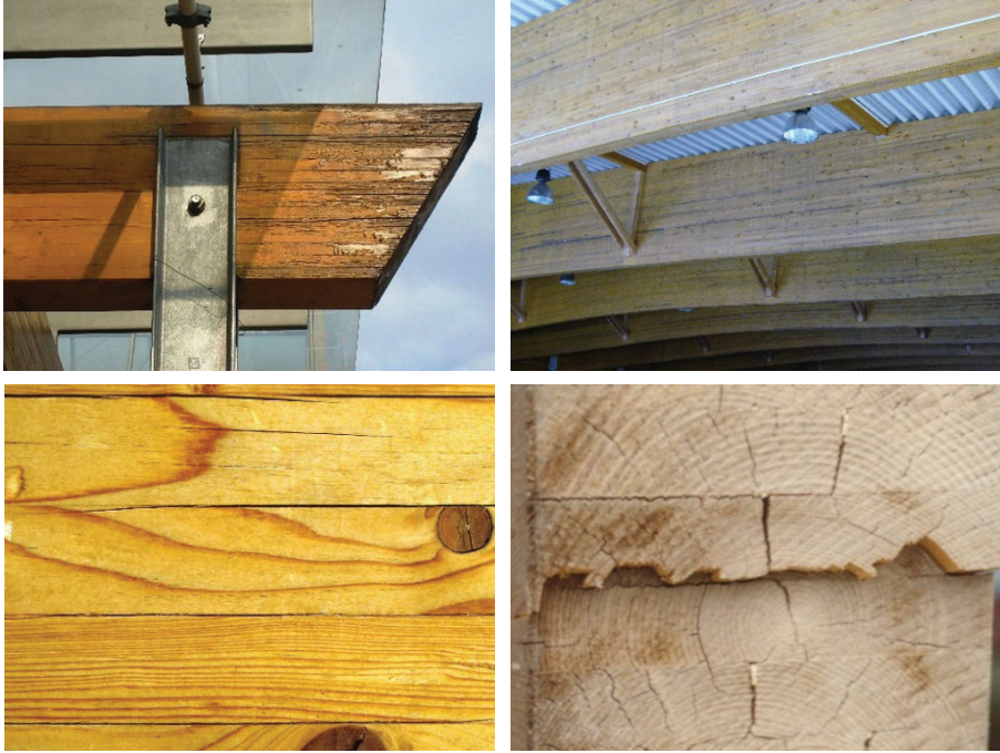
Bild G4-2 Initialschäden – Fäule (oben links), Bläue- oder Schimmelpilze (oben rechts), Risse in Faserrichtung (hier unbedenkliche Schwindrisse, unten links), Schubbruch (Trägerhälfte der Druckzone tritt am Hirnholz hervor, unten rechts).
