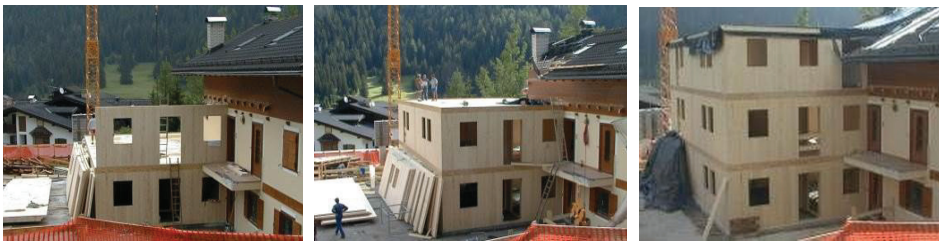
Bild B6-13 Baufortschritt eines BSP-Gebäudes; nach 2, 4 und 6 Tagen. (Rasom S.r.l., Pozza di Fassa)
