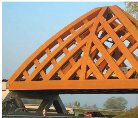
Bild B4-3 Accoya-Brücke in Sneek, Niederlande. (Blaß und Eberhart, Karlsruhe)
