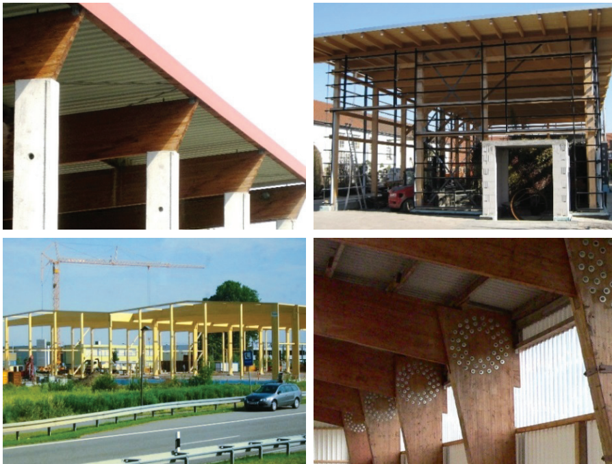
Bild G4-13 Umstände, die zu Schäden führen können: Während der Planung/Ausführung nicht realisierte Gabellagerung (oben links), der Bauphysik zuzuzählende mögliche Rissbildung in BS-Holz durch lokale Aufheizung/Austrocknung hinter geplanten Verglasungen (oben rechts), durch die Montage bedingte Bewitterung von BS-Holz (unten links) und Konstruktion von Dübelkreisen, in denen beim Schwinden Zwangsspannungen wirken (unten rechts).
