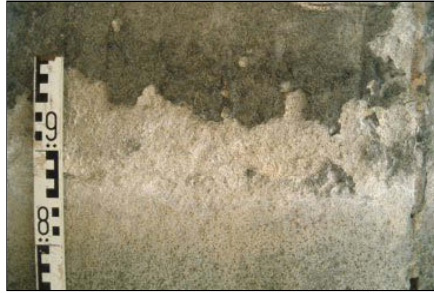
Abb. 2.27: Abtrennen einer Kruste mit anhaftendem Gesteinsmaterial [44]
