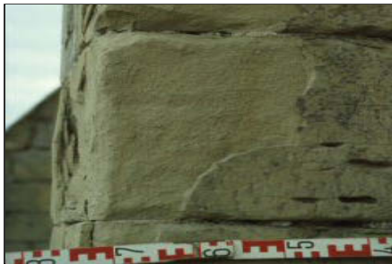
Abb. 2.26: Abschalen (links) und Abschuppen nach einer Schalenbildung (rechts) [44]
