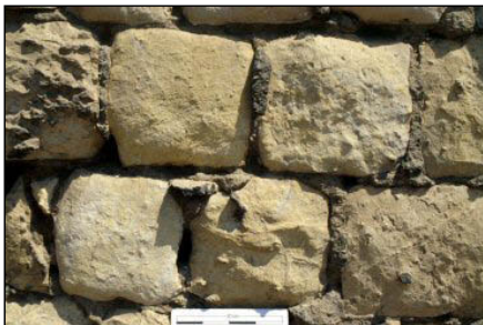
Abb. 2.28: Wollsackverwitterung (links) und Alveolarverwitterung (rechts), Steinbreite links ca. 25 cm, rechts ca. 40 cm [44]
