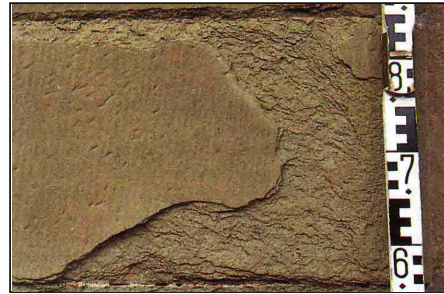
Abb. 2.26: Abschalen (links) und Abschuppen nach einer Schalenbildung (rechts) [44]
