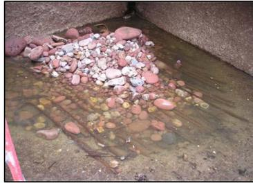
Bild 5.5: Infolge hydroabrasiver Beanspruchung freigelegte und beschädigte Bewehrung einer Bodenplatte (hier: Schleuse)
