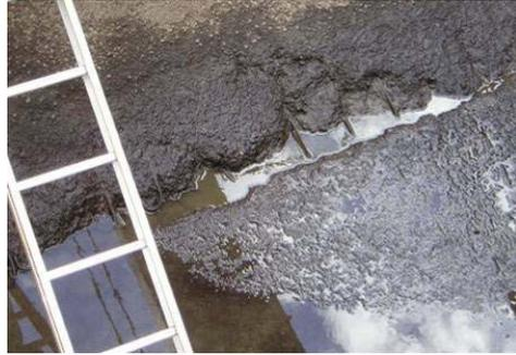
*Bild A-2.4: Verschleißschäden an einer Betonsohle einer Schleuse (Mittelhaupt), (eig. Foto)*
