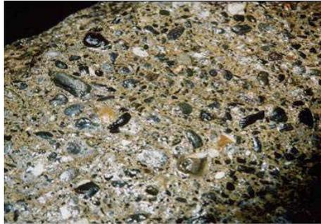
*Bild A-2.1: Verschleißschädigung einer Wehrkrone mit freigelegtem Gesteinskorn [111]*
