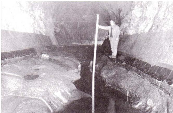
*Bild A-2.3: Verschleißschädigung des Betonbodens eines Umleitstollens [34]*
