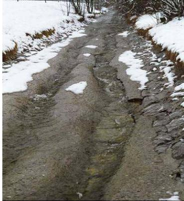
Bild A-2.7: Verschleißschäden in einem Bachbett aus Beton [110]
