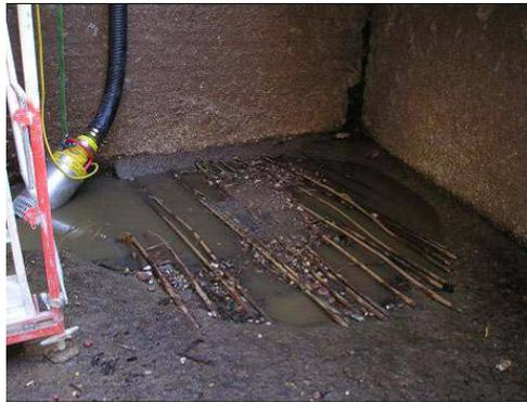
*Bild A-2.5: Verschleißschäden an einer Betonsohle einer Schleuse (Vorboden), (eig. Foto)*
