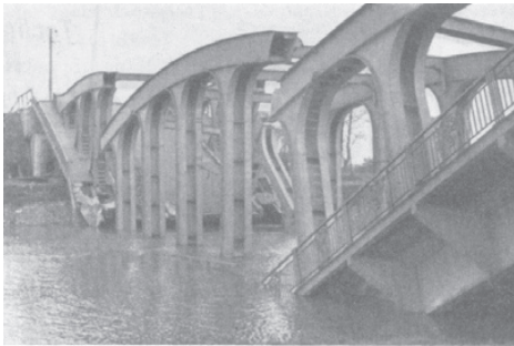
Bild 2.6: Sprödbruch der Brücke über den Albert-Kanal bei Hasselt (1938), die Außentemperatur betrug ca. -20\text{ }^{\circ}\text{C} [83]
