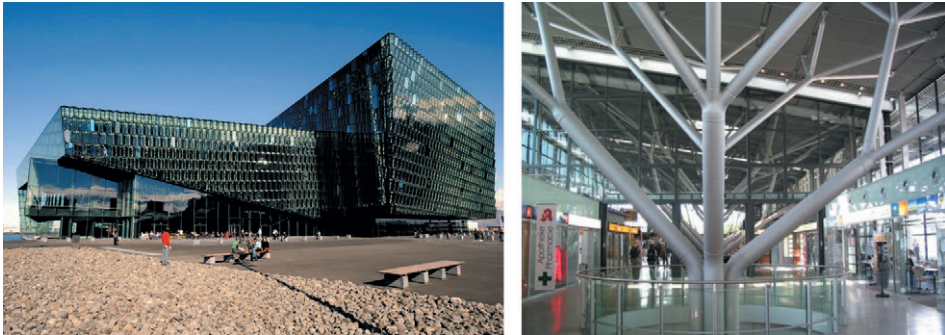
Bild 1.1: Beispiele für den Einsatz von Stahlguss; links: Fassade des Konzert- und Konferenzzentrums Harpa in Reykjavik, rechts: Baumstütze des Flughafengebäudes in Stuttgart
