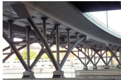
Abbildung 1.2 Hohlprofilkonstruktion im Brückenbau: Humboldthafenbrücke, Berlin
