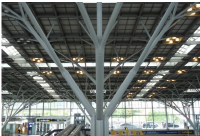
Abbildung 1.1 Hohlprofilkonstruktion im Hochbau: Flughafen Stuttgart
