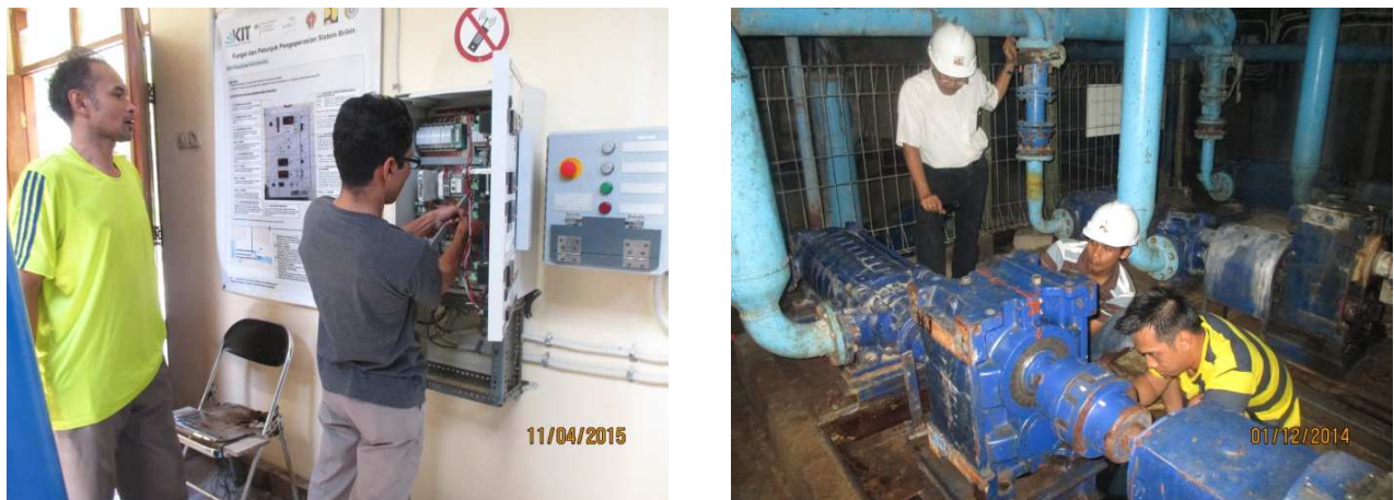
Abbildung 4.10: Wartungsarbeiten am Kontroll- (links) sowie am Fördersystem (rechts) in Bribin durch den lokalen Betreiber
