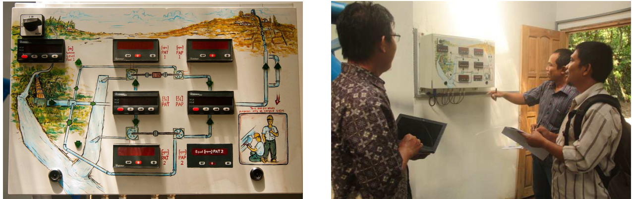
Abbildung 6.6: Deckplatte des Schaltschranks des Monitoring -Systems (links), gestaltet durch einen indonesischen Designer, Nutzung des Messsystems im Rahmen studentischer Praktika (rechts)
