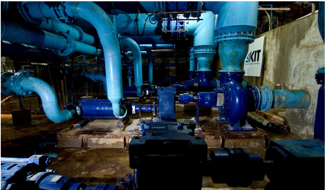
Abbildung 4.2: Das Fördersystem der Anlage Bribin nach der Implementierung der finalen Ausbaustufe 21
