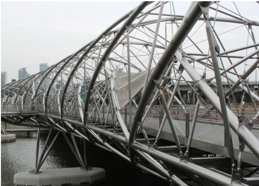
Bild 1.1 Helix Bridge in Singapur, hergestellt aus KHP aus nichtrostendem austenitisch-ferritischem Stahl EN 1.4462
