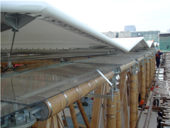
Abb. 12 Montage des Dachtragwerkes
