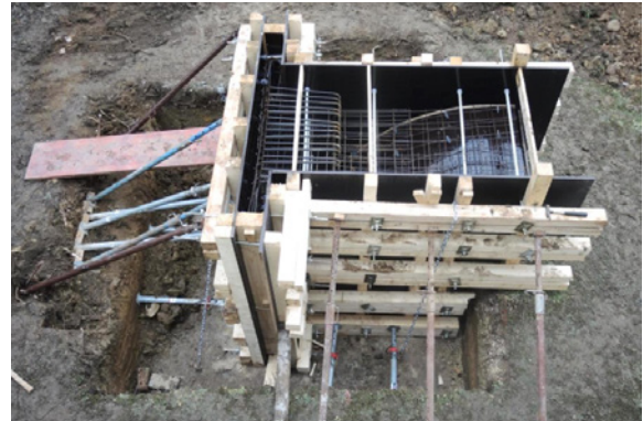
Abb. 16: Ansicht des eingeschalteten Stahlbeton-Widerlagers
