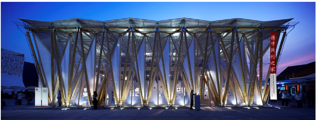
Abb. 4 Ansicht des Pavillons „Deutsch-chinesisches Haus“
