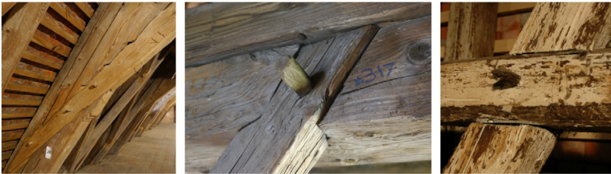
Abb. 13 Typische Blattverbindungen in Dachwerken
