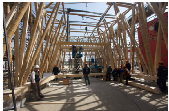
Abb. 11 Montage des Primärtragwerkes
