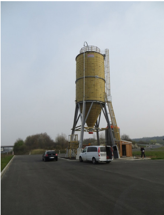
Abb 2: Ansicht Silo (mittelschlank)
