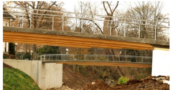
Abb. 4: Integrale Stahlbeton-Holzbrücken (Rokoko- und Bahnhofsbrücke) in Schwäbisch Gmünd (Foto: Schaffitzel + Miebach, 2014)
