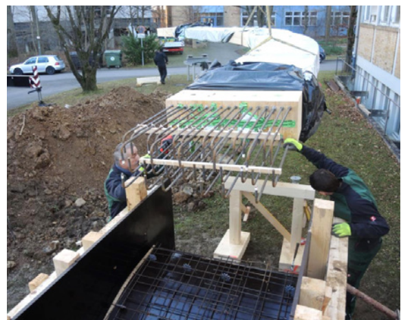
Abb. 17: Einheben des Hauptträgers in das Widerlager zum anschließenden gleichzeitigen Betonieren der Widerlagerwand, Ausvoutung und des Stoßbereiches nach Anordnung der Anschlussbewehrung
