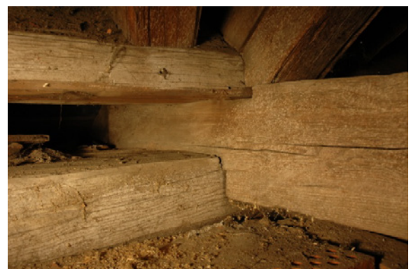
Abb. 9 Kammverbindungen am Stuhlsäulenfußpunkt im Dachwerk der Alten Universität in Graz
