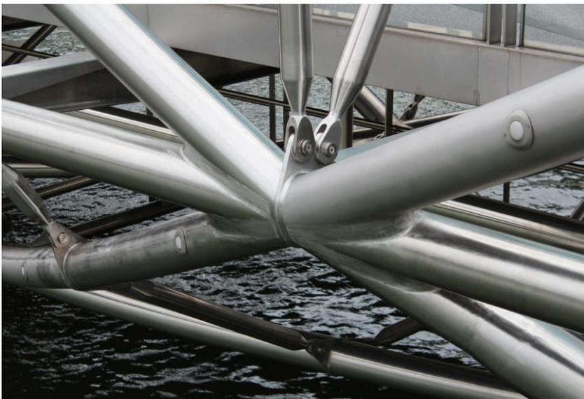
Bild 1.2 DK-Knoten aus KHP mit geschlossenem Querblech der Helix Bridge in Singapur
