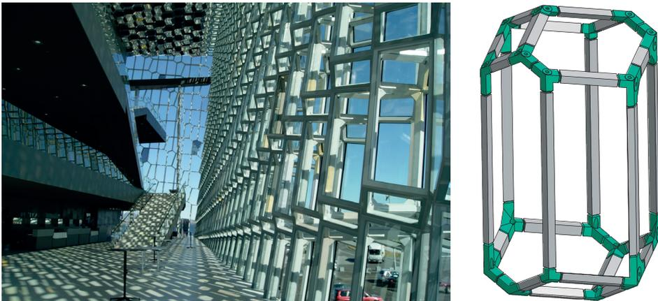
**Bild 3.35:** Links: Bild der Fassade im fertigen Zustand, rechts: Bauteil aus der Fassade des Konzert- und Konferenzzentrum Harpa (Erzeugnisse aus Stahlguss sind grün dargestellt)
