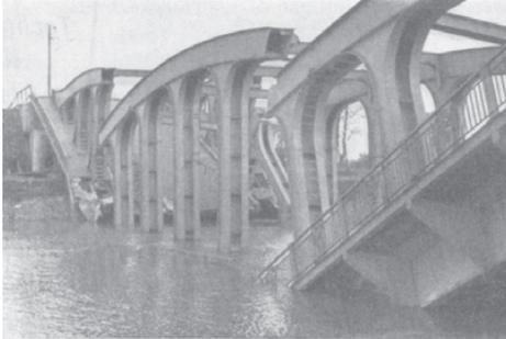
**Bild 2.6:** Sprödbbruch der Brücke über den Albert-Kanal bei Hasselt (1938), die Außentemperatur betrug ca.  $-20\text{ }^{\circ}\text{C}$  [83]
