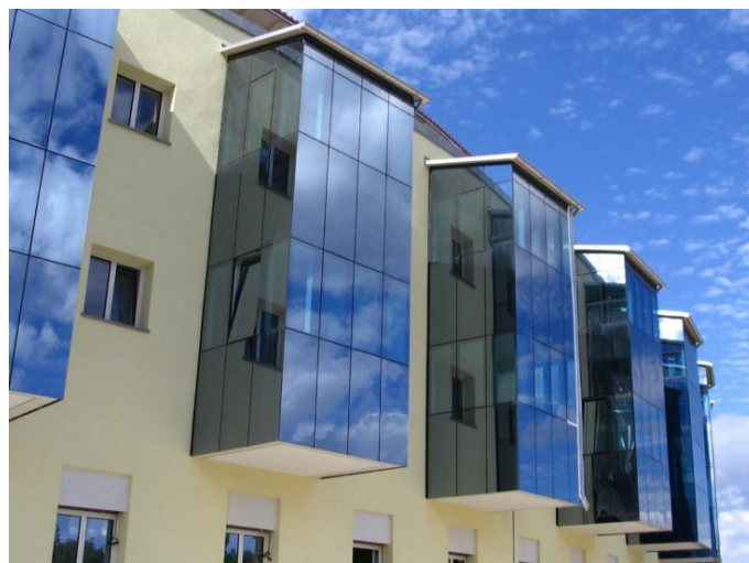
Abbildung 2.16 Structural-Glazing-Fassade, (Bild: Labor für Stahl- und Leichtmetallbau, Hochschule München), (ALBIEZ UND UMMENHOFER 2013)
