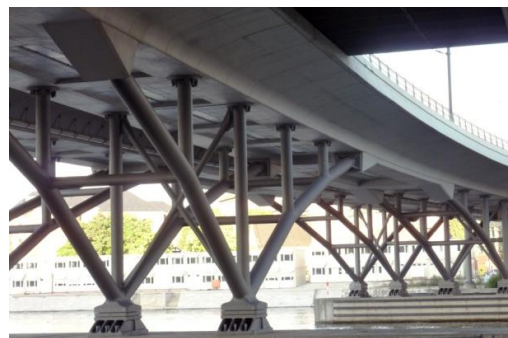
Abbildung 1.2 Hohlprofilkonstruktion im Brückenbau: Humboldthafenbrücke, Berlin
