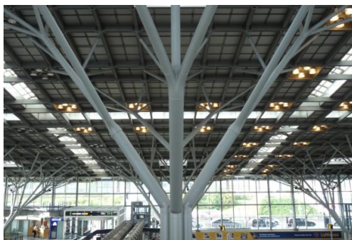
Abbildung 1.1 Hohlprofilkonstruktion im Hochbau: Flughafen Stuttgart
