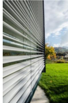
Abb. 2: Aussenansicht Rafflamellensonnenschutz
