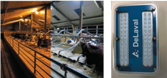
Abb. 1: Versuchsstall mit ursprünglicher NAV- (links) und neuer LED-Beleuchtung (rechts)
