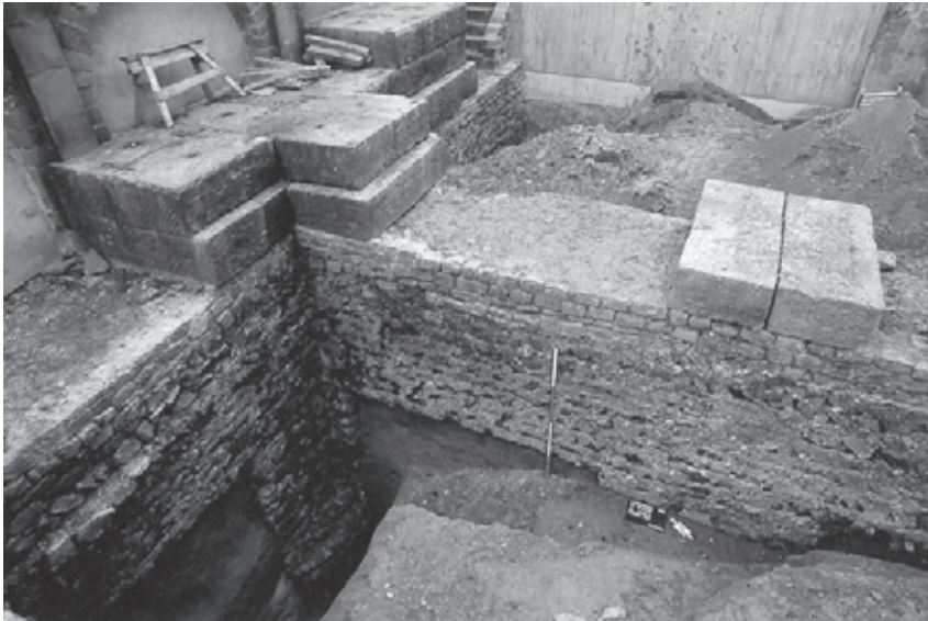
Abb. 5 Lopodunum/Ladenburg. Quaderkonstruktionen der Basilika.
