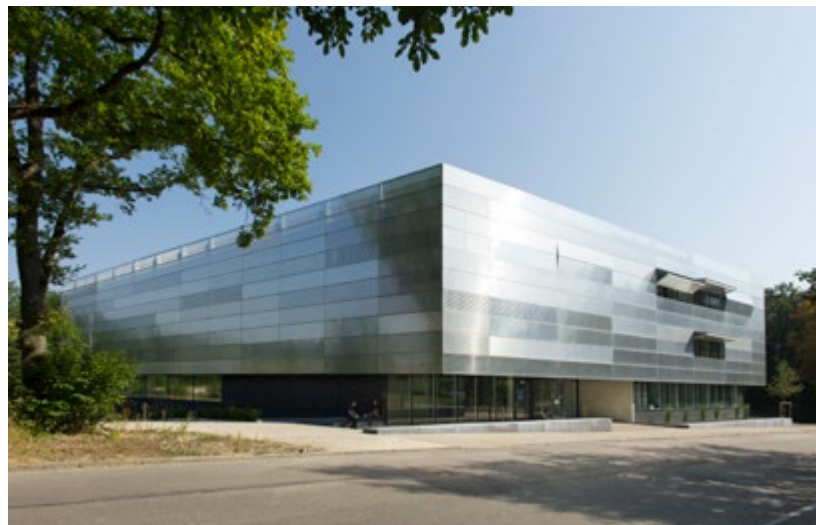
Das Helmholtz-Institut Ulm wurde 2011 gegründet und konnte im Jahr 2014 seinen neuen Forschungsbau mit modernster Labor-Infrastruktur beziehen.
