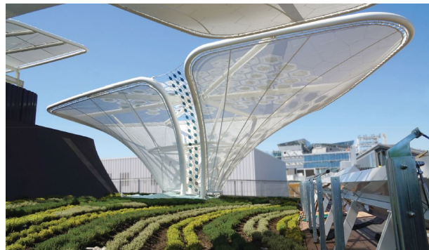
Abbildung 1.2.: Pilotinstallation Organischer Photovoltaik beim deutschen Pavillon auf der EXPO 2015 in Mailand. Organische Solarmodule auf Folien konnten aufgrund ihres leichten Gewichts und der mechanischen Flexibilität in „Solarbäume“ integriert werden. Fotografie entnommen aus Referenz [19], verfügbar unter der Lizenz Creative Commons Attribution 4.0 International (siehe https://creativecommons.org/licenses/by/4.0/ ).
