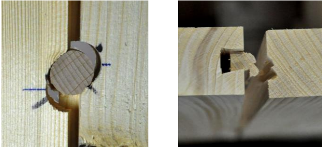
Bild 4-8 Lochleibungsverformung im Fichtenholz sowie Eindrückungen im Dübel (links) und Abreißen der Feder (rechts)
