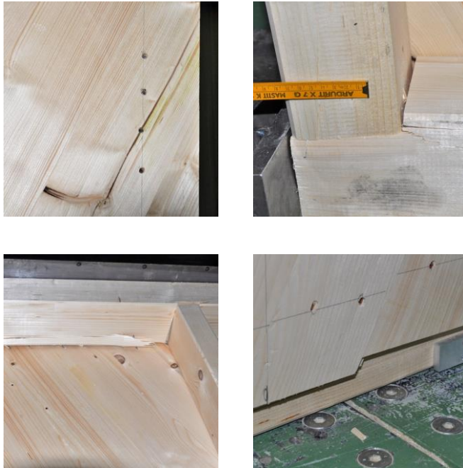
Bild 7-10 Riss in Beplankung oben links, Querdruckversagen der Schwelle oben rechts, Rillennagelverbindung mit Querzugversagen im Rähm unten links und Verschiebung zwischen zwei Brettern der Beplankung unten rechts
