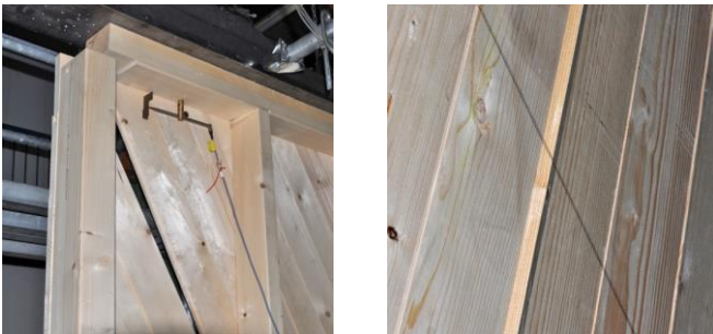
Bild 7-11 Abheben des Rähms und Spalt in Beplankung links und Querzugversagen der Nutflanke rechts
