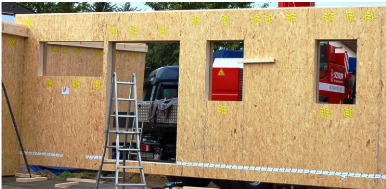
Bild 2-1 Wandtafel mit OSB-Beplankung; Quelle: www.flickr.com
