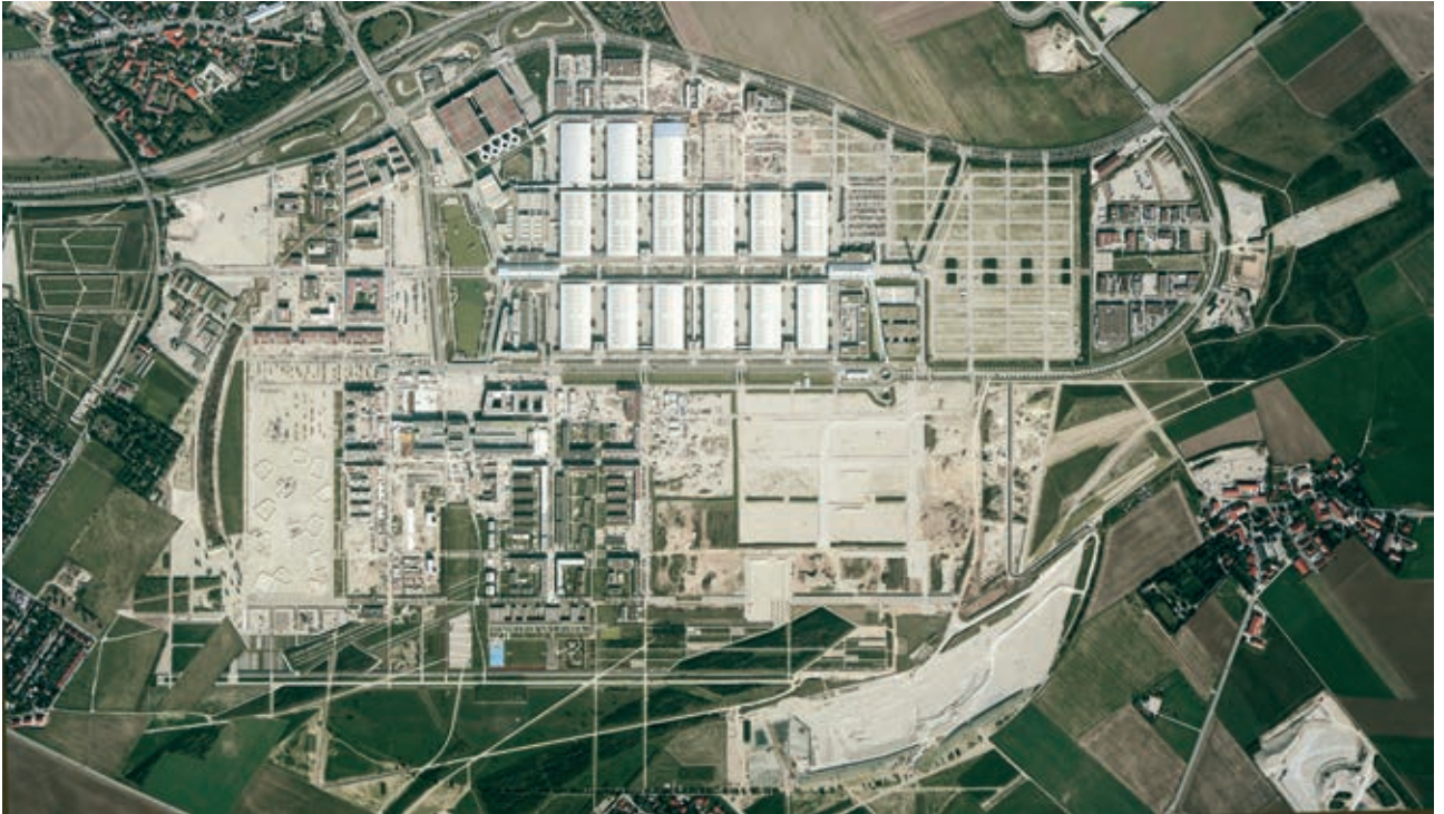
Abb. 57: Baustelle Badesees, rechts unten im Bild (Quelle: MRG Luftbild 2003)
