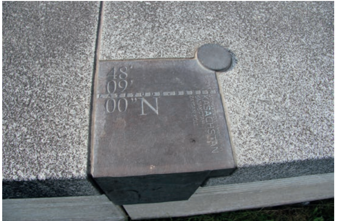
Abb. 24: Bronzeanschluss Terrassenmauer (Foto: Lezuo 2014)
