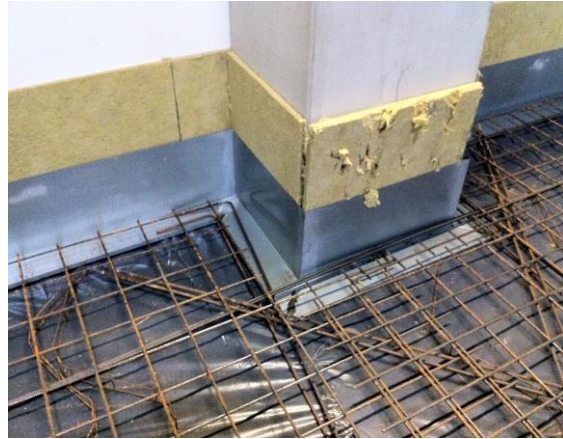
Abb. 11: Fugenabdichtungen mit Fugenblechen
