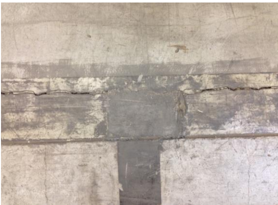
Abb. 10: Abgerissene Fugenflanken
