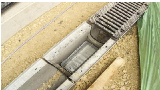
Abb. 8: Kastenrinne aus Fertigteilen (Fugen noch offen)
