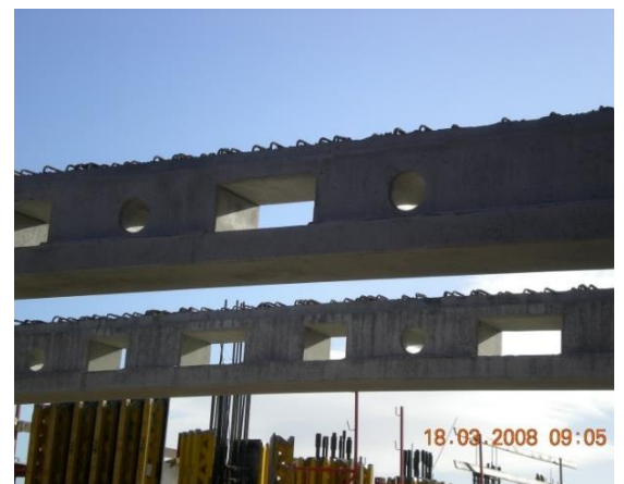
Abb. 19: Spannbetonträger mit großen Stegöffnungen beim Opernturm Frankfurt
