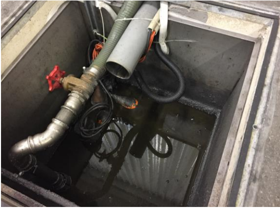
Abb. 9: Pumpensumpf mit Blechauskleidung
