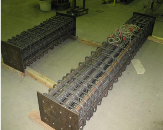
Abb. 29: Bewehrungskorb der Fertigteilstützen mit SAS 670/800 beim Taunusturm Frankfurt [21]
