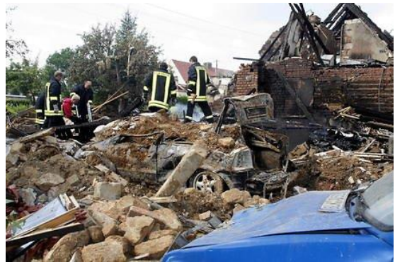
Abb. 4: Gasexplosion in einem Wohnhaus [15]
