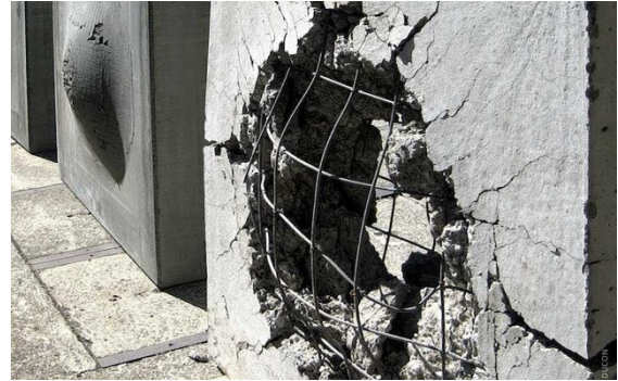
Abb. 6: Links: DUCON-Beton®, rechts: herkömmlicher Beton nach einem Explosionstest [27]
