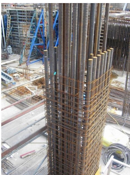
Abb. 25: Bewehrungskorb der Megastütze im Opernturm Frankfurt
