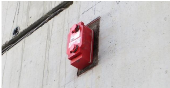
Abb. 33: Stahlkonsole Taunusturm Frankfurt [21]
