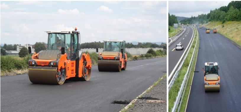
**Abbildung 1:** Tandemwalzen bei der Asphaltverdichtung
