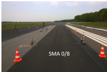
Abbildung 31: Versuchsstrecke 1: Referenzbelag SMA 0/8, Länge 60 m, Breite 3,25 m
