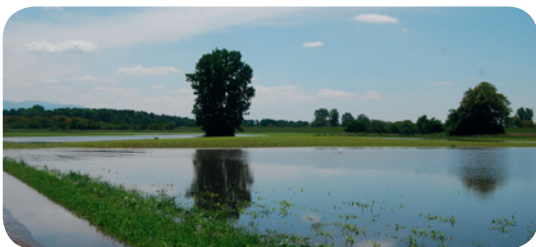
Abb. 70 Druckwasser auf der Landseite des Deiches
