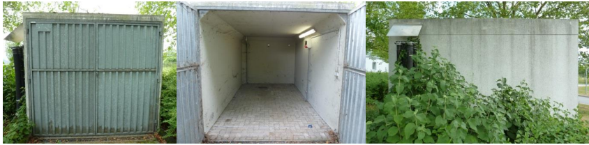
Abbildung 20: Beispielgarage 2 (reale Garage am ICT)
