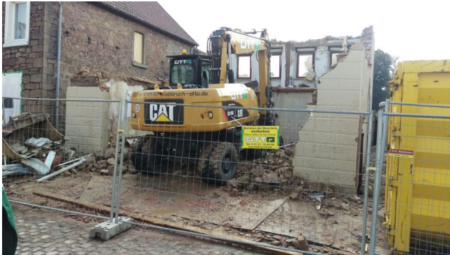
Abbildung 60: Abbruchobjekt Lemgo: Nahezu vollständiger Abbruch der aufstehenden Wände
