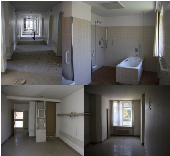
Abbildung 34: Innenraumansichten Krankenhaus Bad Pymont, oben links: Gang, oben rechts: Badezimmer, unten beide: Patientenzimmer (Quelle: Volk, KIT/IIP)
