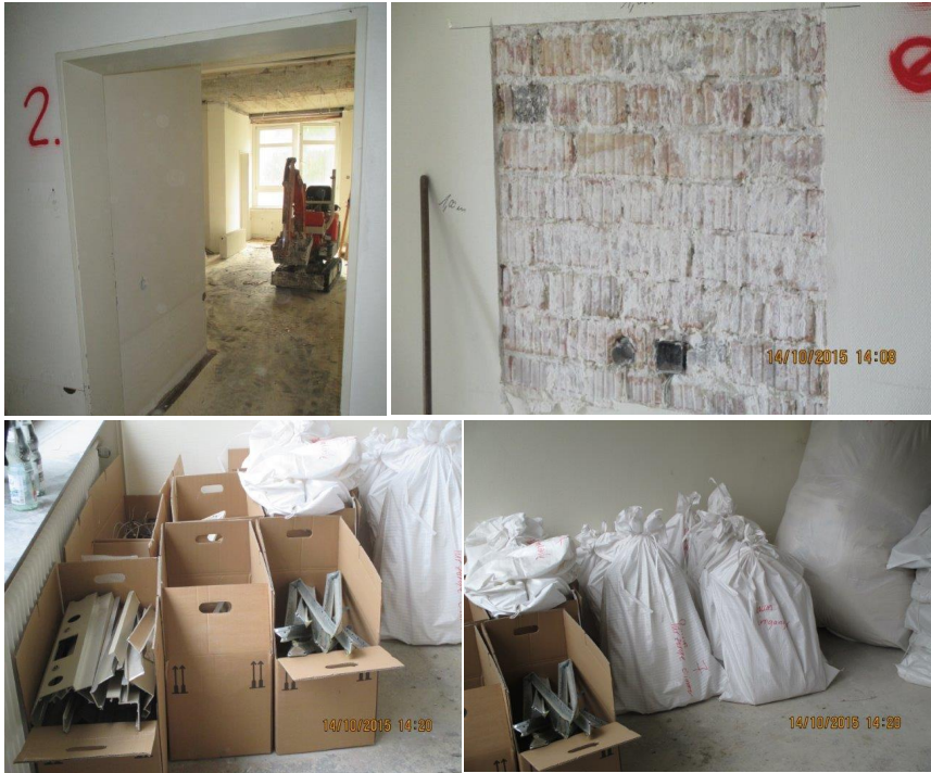
Abbildung 52: Fotos von dem selektiven Rückbau des Krankenhauses in Bad Pyrmont (Quelle: Cosawa GmbH)
