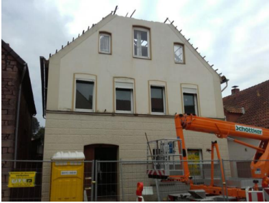
Abbildung 53: Abbruchobjekt Lemgo: Vorbereitetes Gebäude
