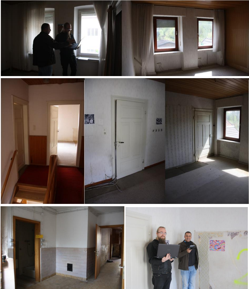
Abbildung 43: Innenraumansichten des Wohnhauses in Lemgo im 1. OG zum Zeitpunkt der Begehung und des Demonstratortests (Quelle: KIT/IIP)
