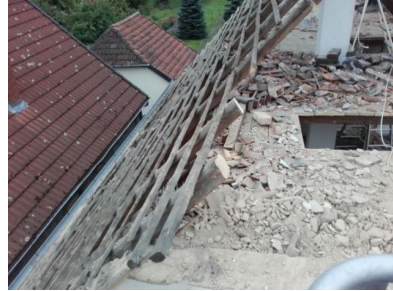
Abbildung 54: Abbruchobjekt Lemgo: Abbruch Dachstuhl per Hand aus Bühne
