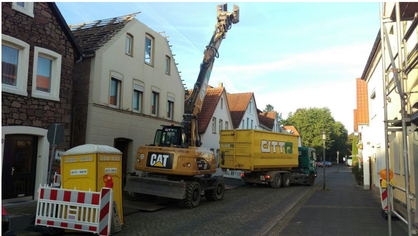
Abbildung 55: Abbruchobjekt Lemgo: Beginn der maschinellen Rückbauarbeiten
