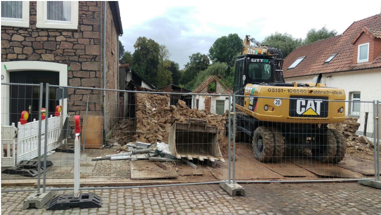
Abbildung 62: Abbruchobjekt Lemgo: Vollständiger Abbruch Gebäude Orpingstraße Lemgo, lediglich die Remisen müssen noch abgebrochen werden
