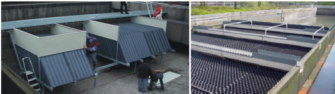
Bild 3: RÜB Aachen Soers (links: Voruntersuchungen an drei unterschiedlichen Röhrenelementen; rechts: nachgerüstetes RÜB, Bildquelle Dohmann et al. (2003))
