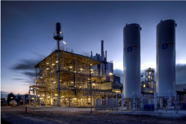
Abb. 55: Pilotanlage bioliq® Rechts im Bild die N 2 - und O 2 -Hochdruckbehälter, links die Anlage zur Kraftstoffsynthese
