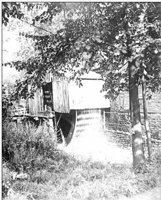
Abb. 5: Radstube mit einem eingebauten Wasserrad der Wassermühle Luhn in Heven bei Witten, um 1930.
