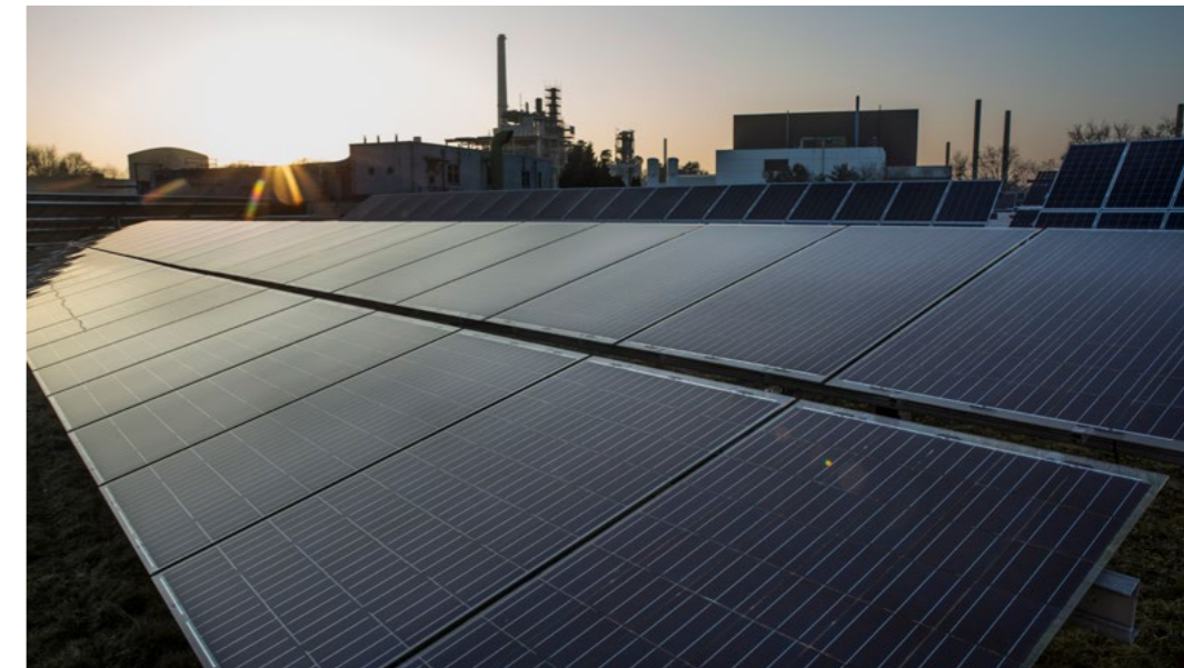
Schwankende Energieproduktion durch erneuerbare Energien stellt hohe Anforderungen an neuartige Energiespeicher.
