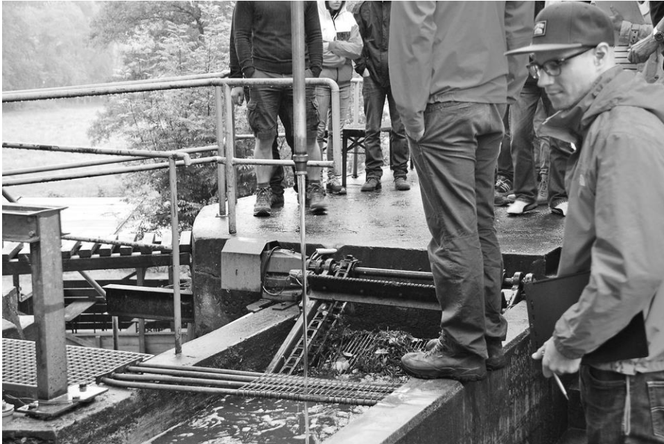
Abbildung 3: Studierende während der Messung des Wasserdurchflusses vor dem Einlauf in die Turbinenkammer [Foto: eigene Aufnahme].
