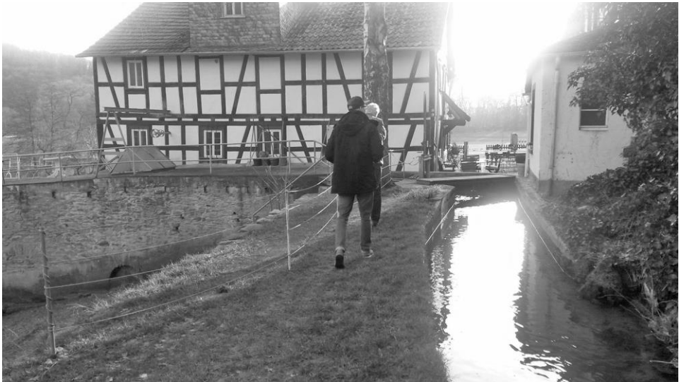
Abbildung 2: Die Hofener Mühle am Kerkerbach im Flussgebiet der Lahn. Die Rückansicht zeigt den langen Mühlgraben, der das Betriebswasser vom Wehr am Kerkerbach zur Wassermühle führt [Foto: eigene Aufnahme & Privatarchiv Dorn].
