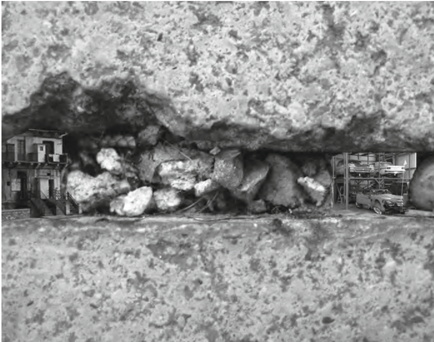
[ 8 ] Entdeckungen im Restraum, Montage Plattenfuge
