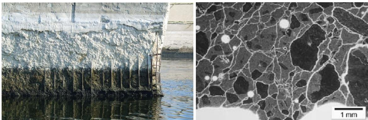
Abbildung 2.1: Frostschädigung am Leitpfeiler eines Wasserkraftwerks an der Wolga in Saratov (links), frostgeschädigtes Betongefüge aus [Fel07] (rechts)
