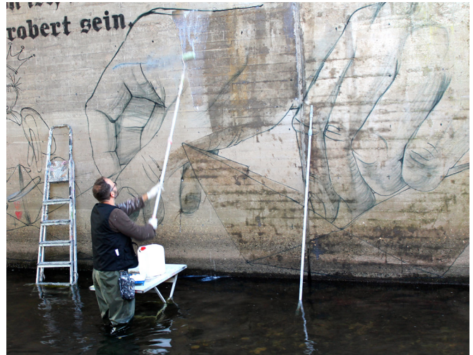
ABB. 115 // DOME, Imagination conquering the world, lasierender Auftrag der Acryl-Tiefengrundierung, Juli 2015, Fassadengestaltung, Acryl- und Sprayfarbe auf Sichtbeton, 4,5 m x 17 m, Karlsruhe, Vogesenbrücke.
