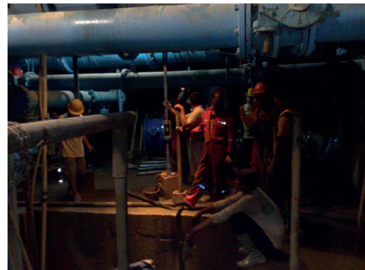
Abbildung 2.1: Die Maschinenplattform während der Bauarbeiten
