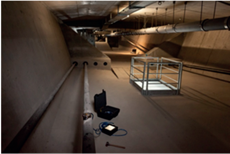
Abb. 2-5: Externe Spannglieder in der Pfingsttalbrücke Nöttingen
