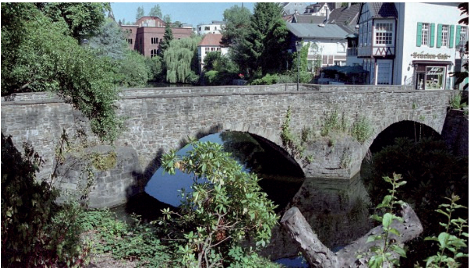
Abb. 4-1: Mühlengrabenbrücke Essen Kettwig [Fotograf: Nicolas Janberg © www.structurae.de]
