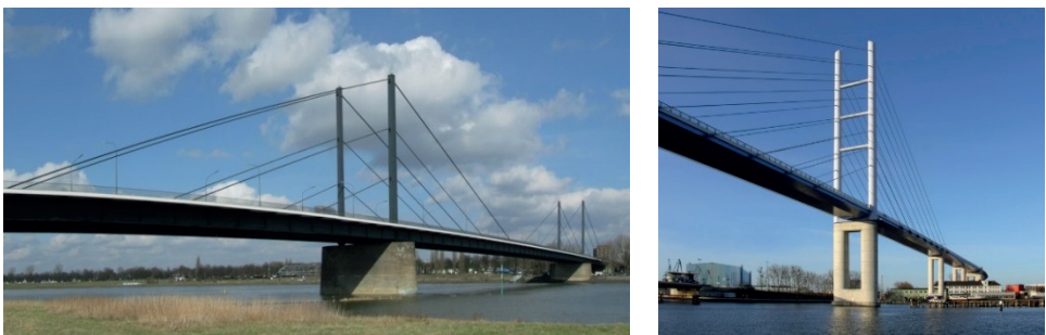
Abb. 2-13: Theodor-Heuss-Brücke in Düsseldorf (links) [Quelle: www.grassl-ing.de ], Rügenbrücke in Stralsund (rechts) [Fotograf: Henner Damke © www.fotolia.de ]
