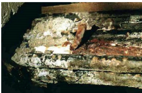
Abb. 2-8: Zustand eines Spannglieds im Bereich des Endquerträgers (links), gerissenes Spannglied der Überführung in Guildford (rechts) [161]
