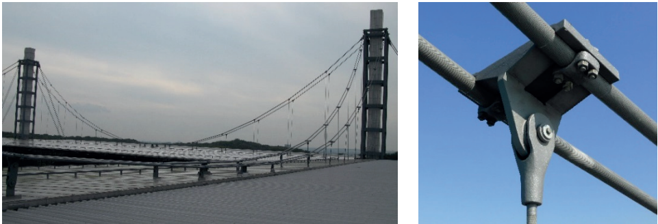
Abb. 6-36: RheinEnergieStadion Köln, Verlauf der Tragseile und Hänger (links), Seilklemme (rechts)
