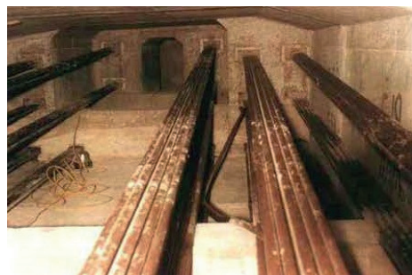
Abb. 2-8: Zustand eines Spannglieds im Bereich des Endquerträgers (links), gerissenes Spannglied der Überführung in Guildford (rechts) [161]
