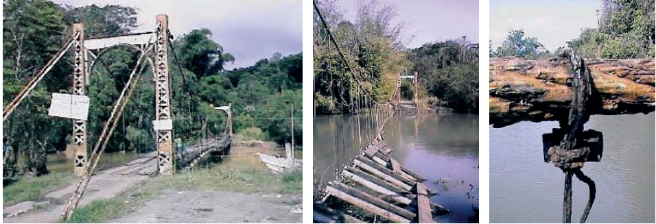
Abb. 2-19: Lance-Mitan-Brücke über den Moruga-Fluss in Trinidad vor und nach dem Einsturz 1998 [85]
