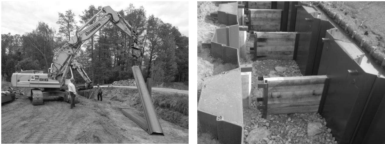
Abbildung 2: Links: Vorbereitung zum Einbringen der Spundbohlen mittels Vibrationsramme, rechts: Schlitzpass mit Spundwänden als Tragkonstruktion
