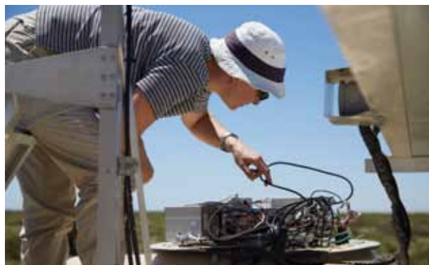
Arbeiten an der Elektronik einer Detektorstation in der Pampa
