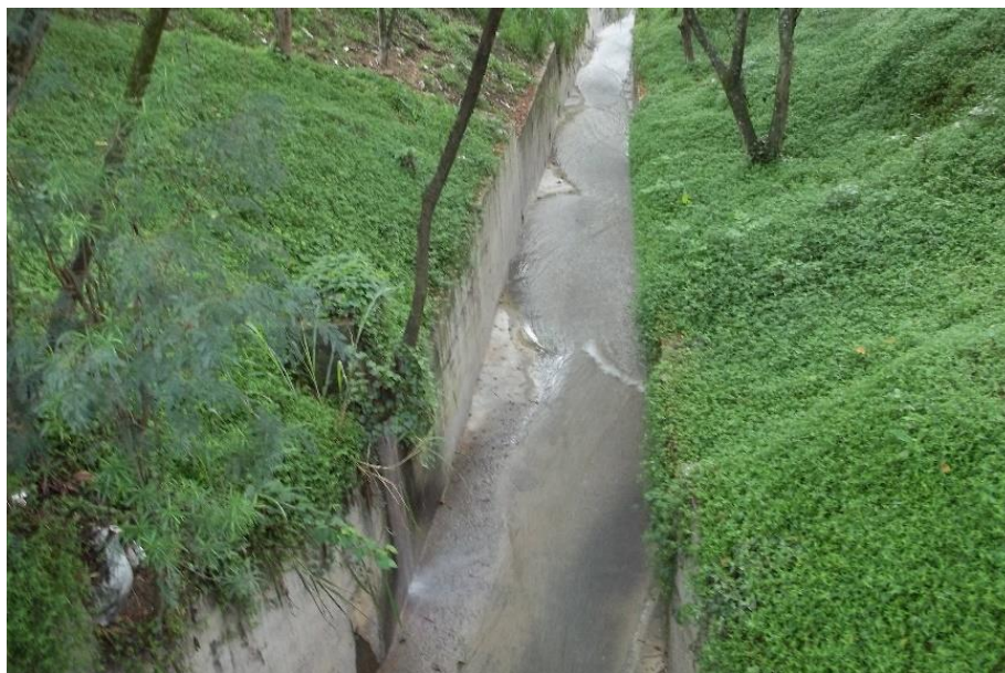
Abbildung 22. Fließgewässer La Ana Díaz (Abschnitt 4) ohne Direkteinleitung aus der Produktion von Zuschlagsstoffen im Steinbruch (Bild: Luisa Roldan)
