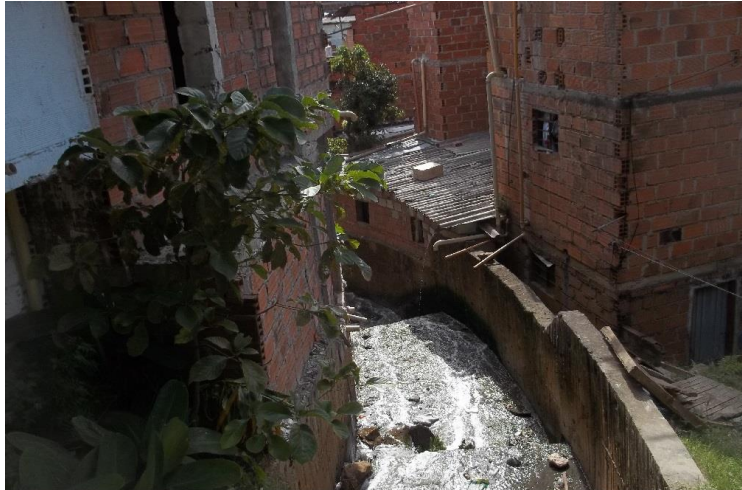
Abbildung 30. Beispiel 1: Fließgewässerabschnitt ohne Gewässerrandstreifen (jedoch mit langfristig nutzbaren Potenzialen) (Fließgewässer La Rosa – Bild: Luisa Roldan)
