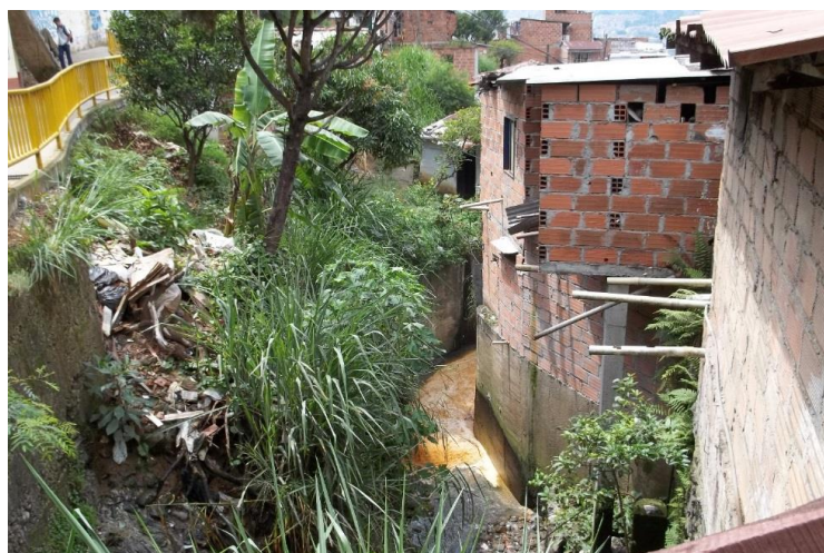
Abbildung 32. Beispiel 1: Fließgewässerabschnitt mit Gewässerrandstreifen (kurzfristig nutzbare Potenziale) (Fließgewässer El Aguacatillo – Bild: Luisa Roldan)
