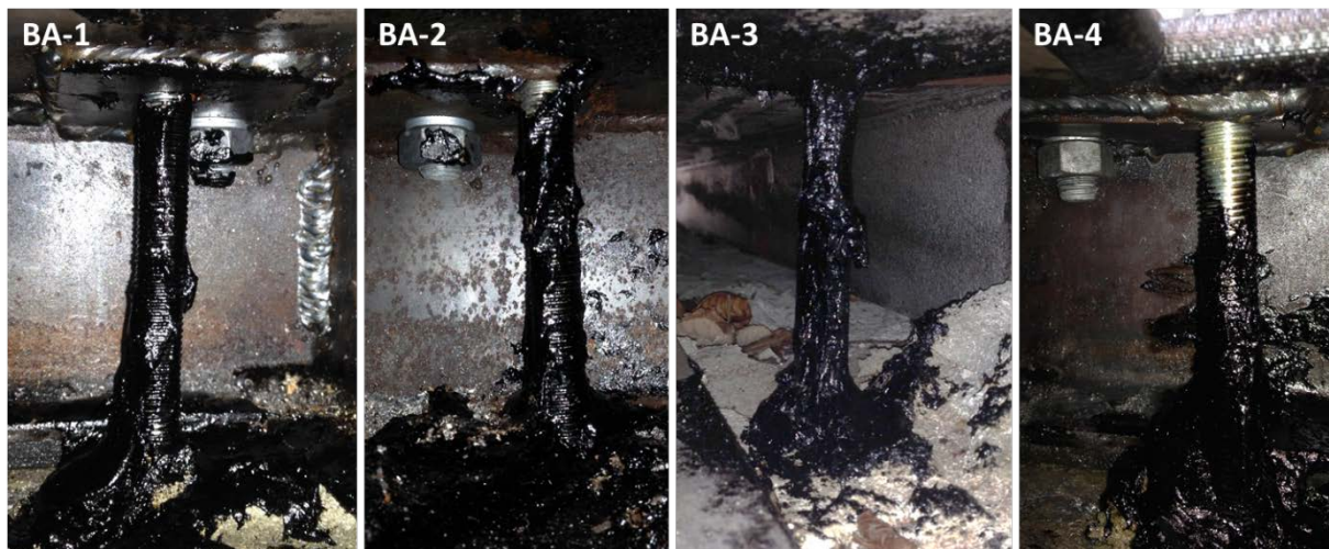
Abbildung 21: Mit Bitumen-Spachtelmasse versiegelte Betonanker BA-1 bis BA-4.
