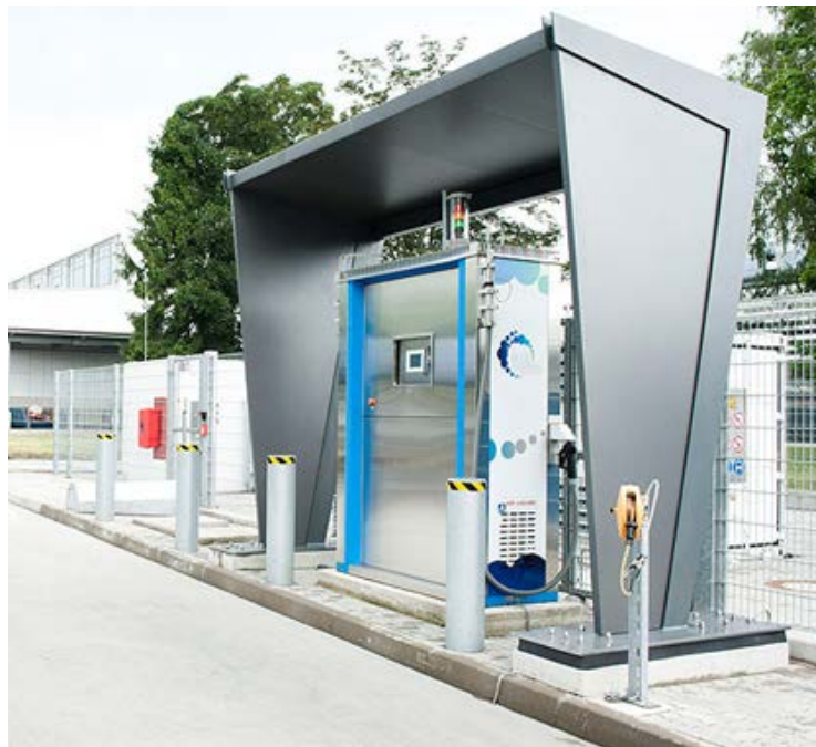
Abbildung 7: Zapfsäule mit Blick auf den 700 bar-Zapfpunkt
