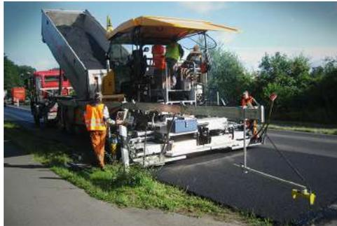
Abbildung 3.3: Sonic Ski am Straßenfertiger zur Schichtdickenmessung
