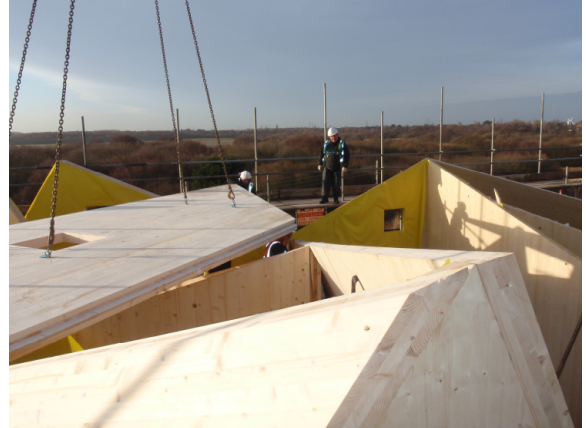
Abb. 5 Dune House Montage Dach
