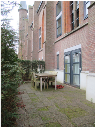
Abb. 153 Privat verfügbare Freiräume im Erdgeschoss in Form von Terrassen und Gartenanteilen. Dazu werden die Fassaden geöffnet um eine direkte Zugänglichkeit von Innenraum und Außenraum zu ermöglichen. (Bsp. 35)
