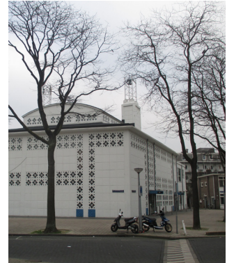
Abb.80 Erhaltene Fassadestruktur der Kirche
