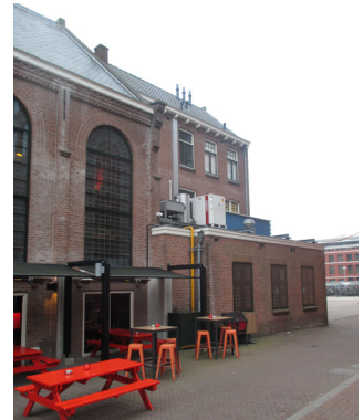
Abb.108 Bauliche Öffnung zur Außengastronomie
