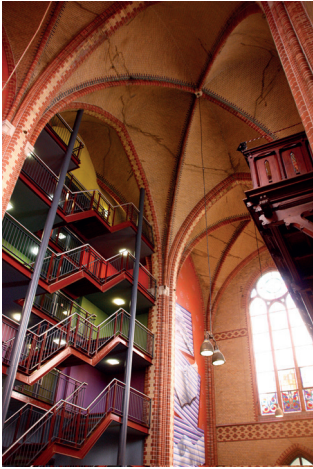
Abb. 159 Vollständiger Ausbau, abgesehen vom Joch im Eingangsbereich, der Heilig Hart Kerk in Haarlem.
