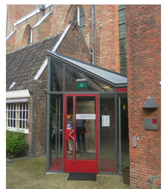
Abb.95 Anbau eines Windfangs als neuer Zugang
