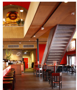
Abb.110 Einzug einer horizontalen Ebene zur Schaffung von mehr Fläche im Gasträum
