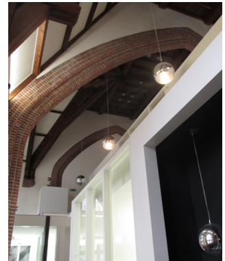
Abb.47 Einbau eines zweigeschossigen Baukörpers
