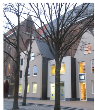
Abb.104 Ergänzende Anbauten an den Bestand
