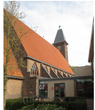
Abb.36 Verbindungsbau zw. Kirche und Pfarrhaus
