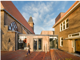
Abb. 129 Verbindungsgebäude zwischen Kirche und Pfarrhaus mit dahinterliegender Gymnastikhalle. (Bsp.3)
