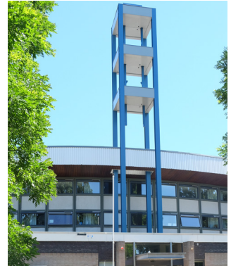
Abb.71 Erhalt der Gebäudestruktur und des Glockenturms
