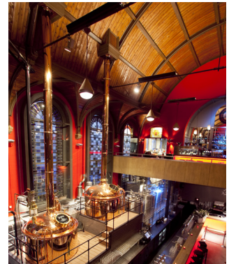
Abb.109 Position der Braukessel im Innenraum
