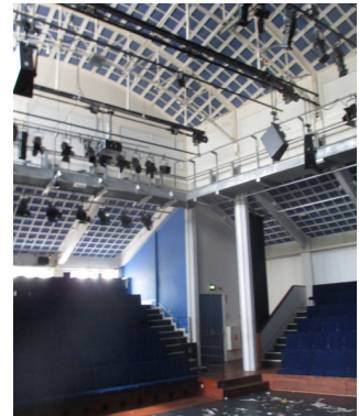
Abb.81 Bereich des Theaters im Obergeschoss
