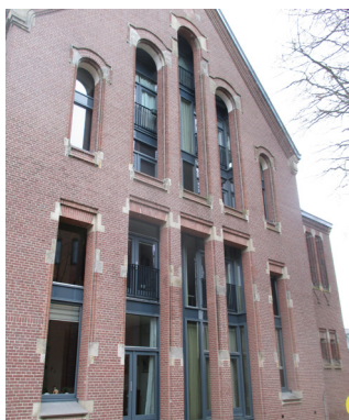
Abb.121 Anpassung der Fassade durch neue Einteilung der Fensterfront
