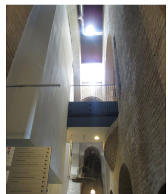
Abb.59 Konstruktive Trennung zwischen Neu und Bestand
