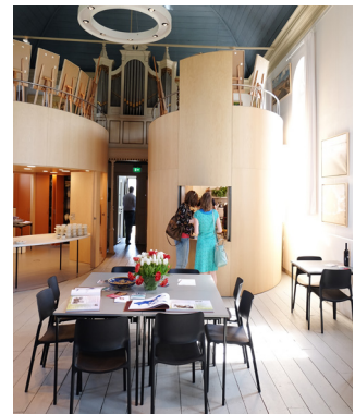
Abb.100 Einbau von zwei aus Holz bestehenden Serviceunits
