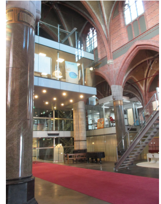
Abb. 150 Büronutzung auf freistehenden, reversiblen Einbauten in der St. Annakerk in Breda. Durch die transparent gehaltenen Einbauten werden unabhängige Units geschaffen. (Bsp. 30)
