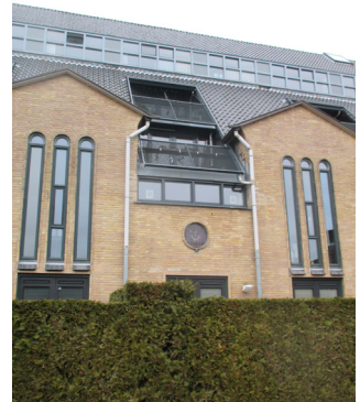
Abb.126 Einbauten von Loggien und zusätzlichen Fenstern
