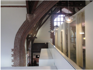
Abb. 133 Beispiel einer Haus- im Haus Lösung über zwei Ebenen. Auf Erdgeschosssebene befinden sich die Behandlungsräume. Darüber liegend Umkleide- und Sozialräume. (Bsp.6)
