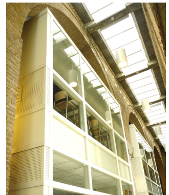
Abb.69 Erhalt von baulichen Strukturen in der Umnutzung
