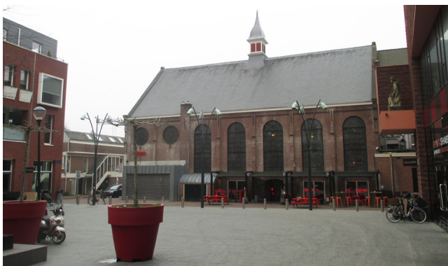
Abb.107 Position der Jopenkerk am Quartiersplatz
