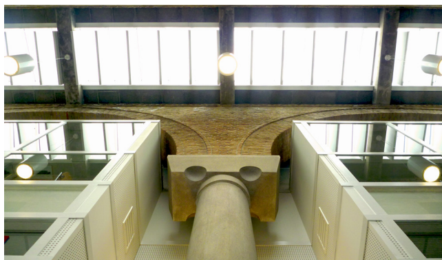
Abb.67 Einfügen der neuen Struktur zwischen die bestehenden Joche der Kirche
