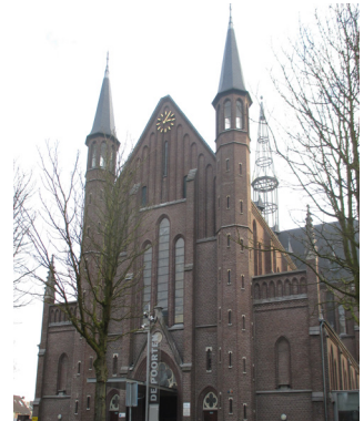
Abb.39 Ansicht des Kircheneinganges
