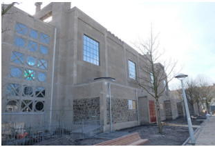
Abb. 157 Beton brut und Pre-fab Techniken sind die Grundlage für den kulturhistorischen Stellenwert der St. Josephskirche in Amsterdam und den Status als Reichsdenkmal. (Bsp. 28)
