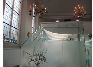
Abb. 134 Reversibel eingefügter Baukörper, der sich durch die Form vom Bestand abhebt. (Bsp.7)
