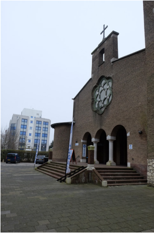
Abb. 147 Das Grundstück des Kirchengebäudes wird seitlich zum Parken genutzt. (Bsp.29)
