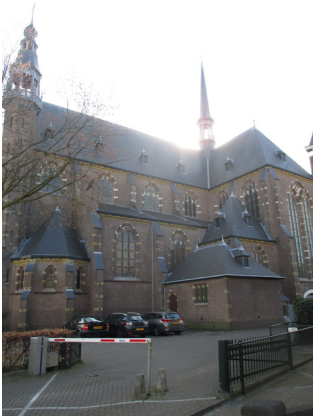
Abb. 149 Das umgebende Grundstück wird fast ausschließlich zum Parken genutzt. (Bsp.30)
