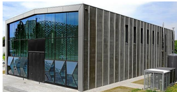
Abbildung 1: Maschinenfabrik aus hybriden Betonfertigteilen
