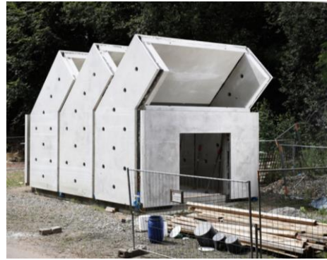
Abbildung 8: Smallhouse IV im Rohbauzustand 2017
