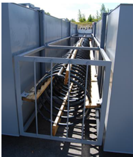
Abbildung 6: Spiralwärmetübertrager zwischen den Pontonteilen eines schwimmenden Hauses
