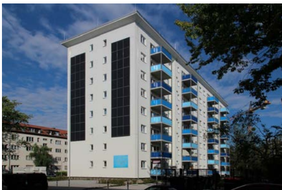
Abbildung 1: Südöstliche Fassadenansicht des degewo ZKH.
