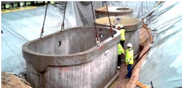
Abbildung 7: Einbau der drei Betonwasserspeicher
