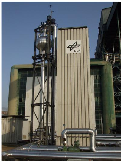
(a) PCM-Speicher im Testbetrieb (Quelle: DLR).
