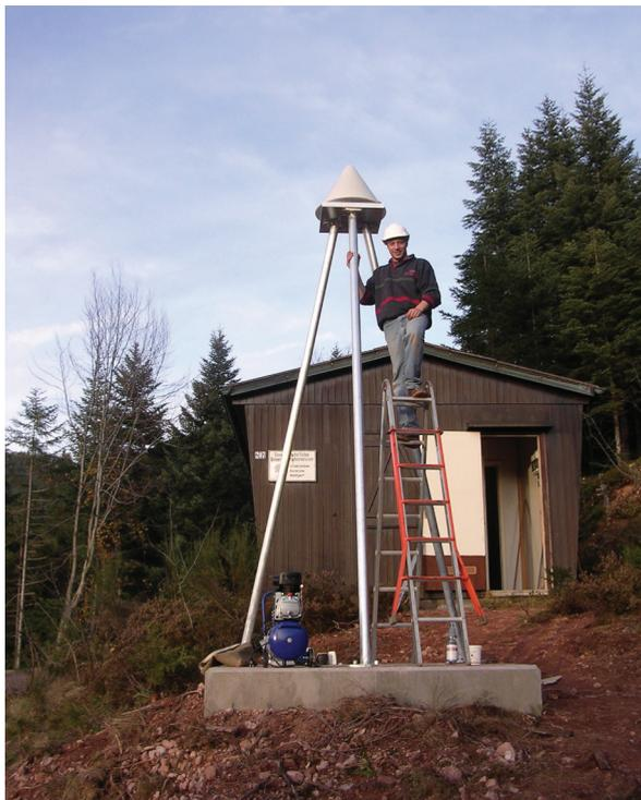
**Abb. 132:** Peter Duffner bei der Installation der permanenten GNSS-Antenne. Im Hintergrund befindet sich die Messhütte, in der sich u. a. Instrumente zur regelmäßigen Messung der Orientierung des Erdmagnetfeldes befinden.
