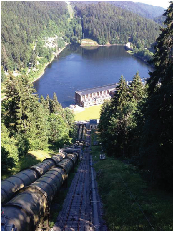
Abb. 85: Hangrohrleitung Häusern.
