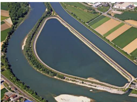
Abb. 83: Foto: Schluchseewerk AG.
