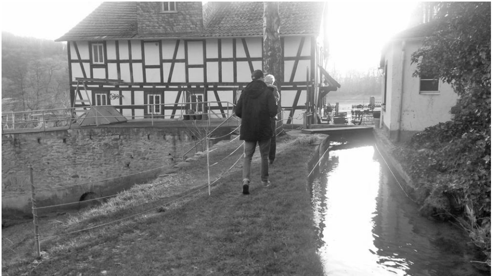
Abbildung 2: Die Hofener Mühle am Kerkerbach im Flussgebiet der Lahn. Die Rückansicht zeigt den langen Mühlgraben, der das Betriebswasser vom Wehr am Kerkerbach zur Wassermühle führt [Foto: eigene Aufnahme & Privatarchiv Dorn].
