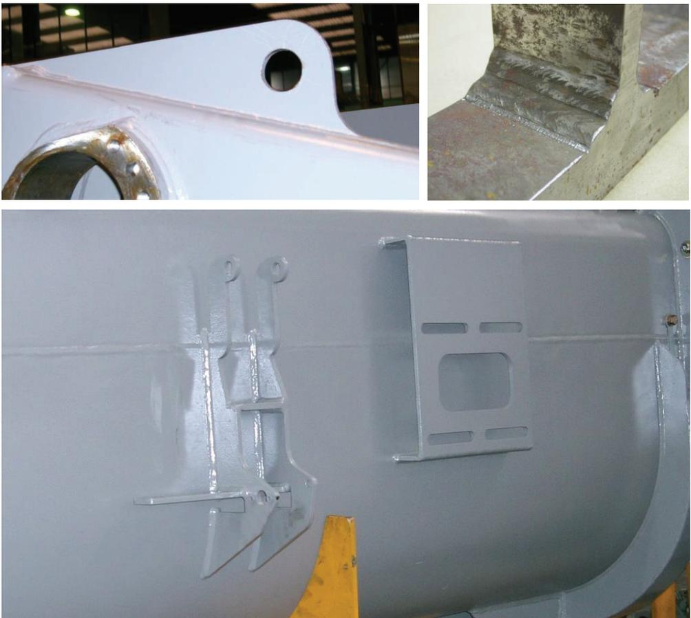
Abbildung 26: Beispiele für aufgeschweißte Steifen
