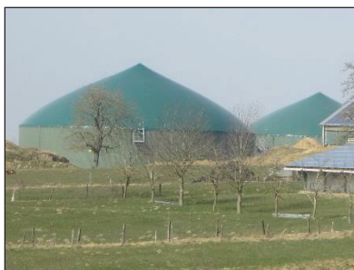
Bild: Biogasanlage (Aufnahme: Kira Schumacher)
