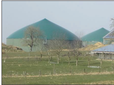
Bild: Biogasanlage (Aufnahme: Kira Schumacher)
