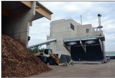
Imagen: Central de biomasa (Fuente de imagen: Sensenschmied, https://commons.wikimedia.org/wiki/File:Biomassekraftwerk_mit_Lager.jpg , „Biomassekraftwerk mit Lager“, https://creativecommons.org/licenses/by-sa/3.0/legalcode )
